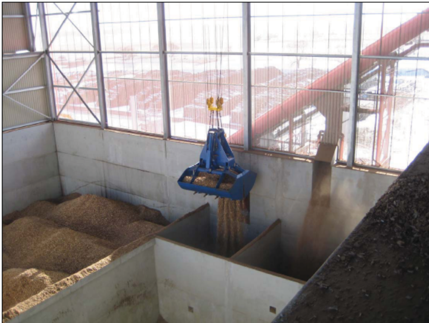
SLIKA 5. Skladište drvne sječke
