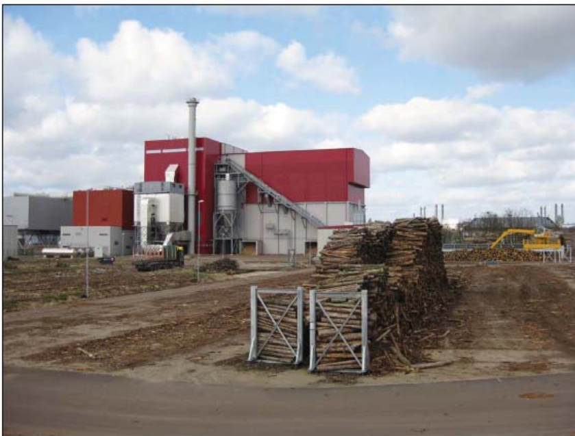
SLIKA 3. Vanjska skladišta trupaca
